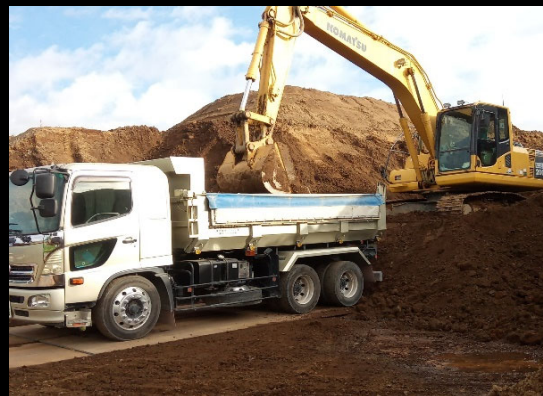
土砂積込み状況
