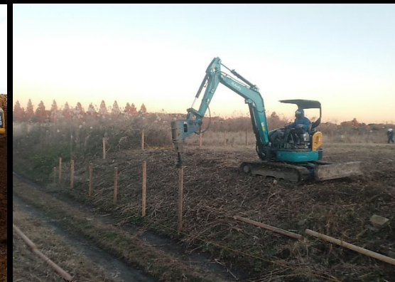
立入防止柵設置
